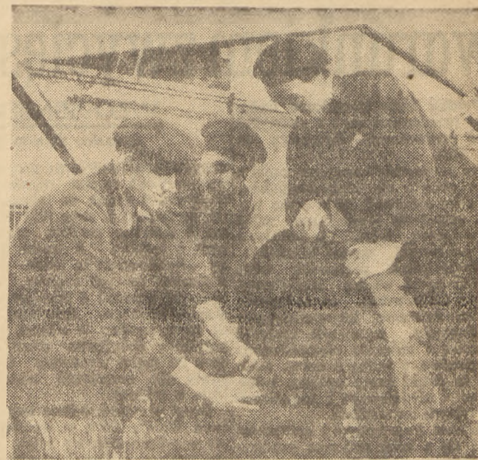
Brigada Jana Kowalskiego z Sopotkiego Przedsiębiorstwa Remontowo-Budowlanego wypracowała przeciętnie 203 proc. normy. Brigada ta dzięki dobrej organizacji pracy podnosi regularnie swoją wydajność od pierwszych dni stycznia br.
