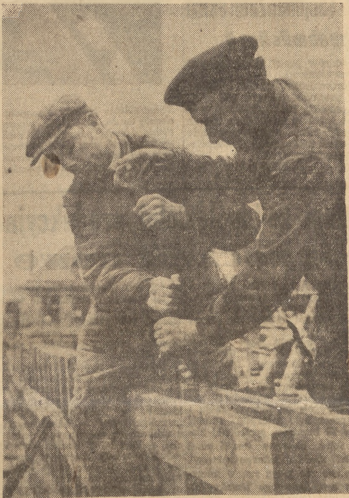
Prace przy budowie wielkiego kina przy ul. Długiej trwają pomimo zimy. Na zdjęciu: członkowie brygady Kieśnikiewicza: Feliks Romejko i Paweł Walentyłowicz, którzy wyrabiają przeciętnie 260 proc. normy.
