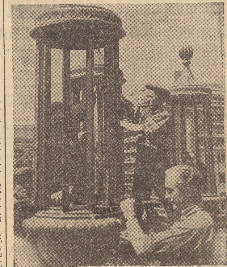
Piękną ozdobą placu MDM będą kandelabry. Na zdjęciu: brygada monterów Eugeniusza Zielińskiego zakłada latarnie na ramiona kandelabru. CAF — fot. Szyperko
