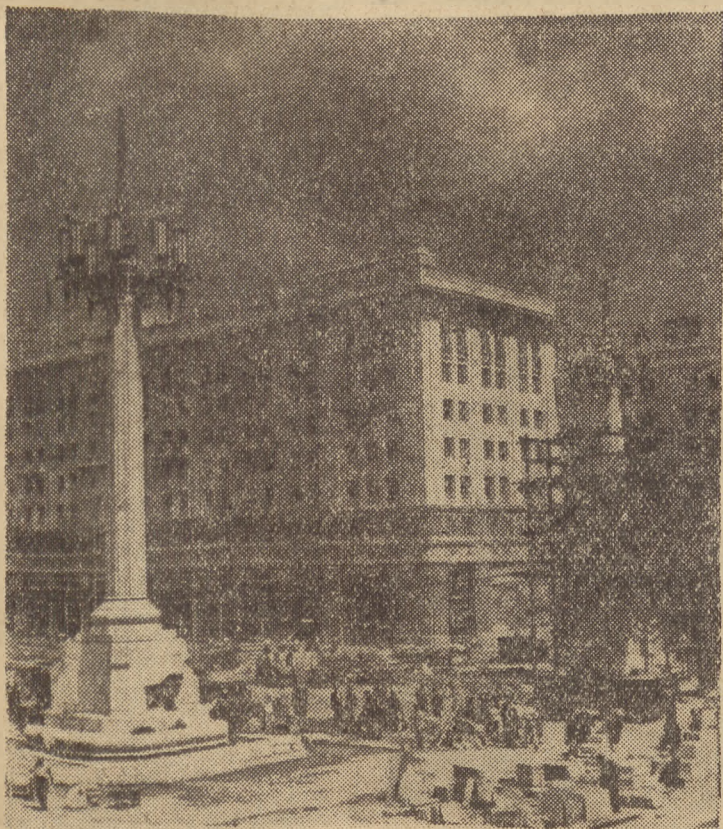
Na placu MDM w stolicy wre gorączkowa praca. Wykańczane są ostatnie roboty. M. in. zdejmowane są już rusztowania z kandelabrow, które będą ozdoba placu. — GAF — fot. Zdz. Wdowiński
