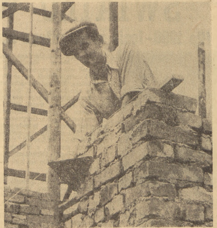
Załoga ZB-2 budująca nowe domy przy ul. Piwnej na Starym Mieście w Gdańsku, stale podnosi wydajność pracy i skutecznie walczy o oszczędność i racjonalne zużycie materiałów budowlanych. Na zdjęciu: murarz Alfons Bzowski, który na budowie nr 40 p., przy ul. Piwnej, osiąga 200 proc. normy
