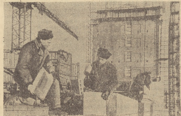
Na Wybrzeżu Dorogomiłowskim znajduje się w budowie 32-piętrowy hotel.
