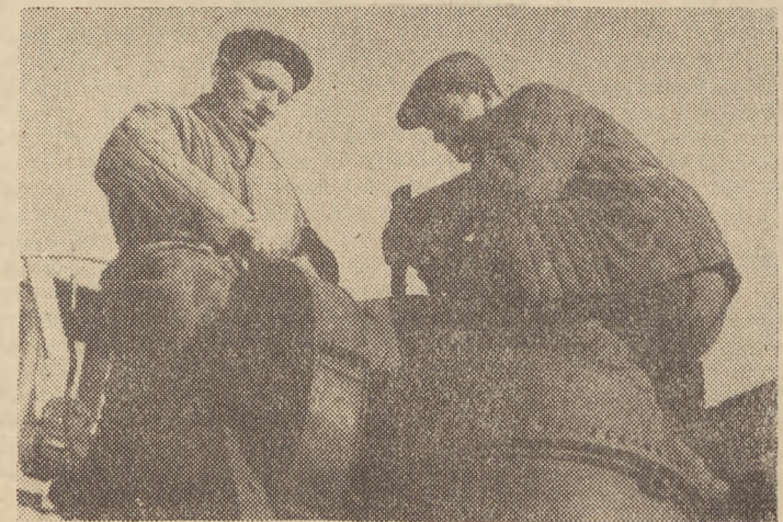
Na zdjęciu: brygadziści Deroń oraz członek brygady Franciszek Klank remontują zepsutą betoniarę. Murarze mogą być spokojni. Remont będzie wykonany dobrze i w terminie.
