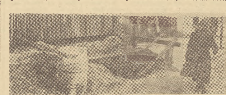
Ten dół na ul. Klinicznej we Wrzeszczu wykopano w połowie ub. roku
