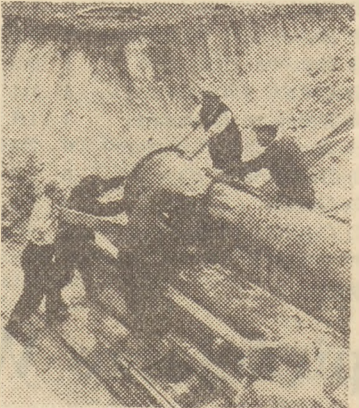
Budowa rurociągu Pilica-Lódź. Układanie rur w rowie.
