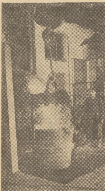
Spust stali w odlewni stalowa Nowej Huty
