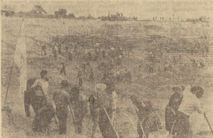
Szybko postępują prace przy budowie Parku Kultury i Sportu im. 23 Sierpnia w Bukareszcie, gdzie odbywać się będą imprezy sportowe i artystyczne.
