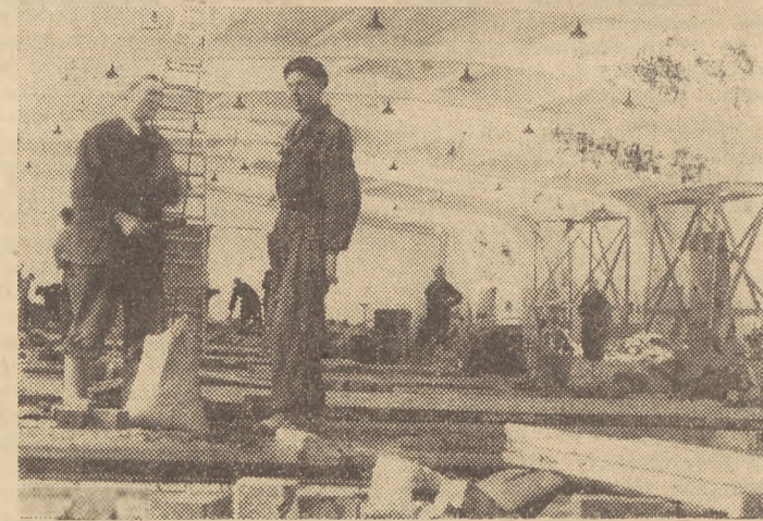
Wnętrze hali napraw samochodów osobowych znajduje się już na ukończeniu. Foto Z. Kosycarz
