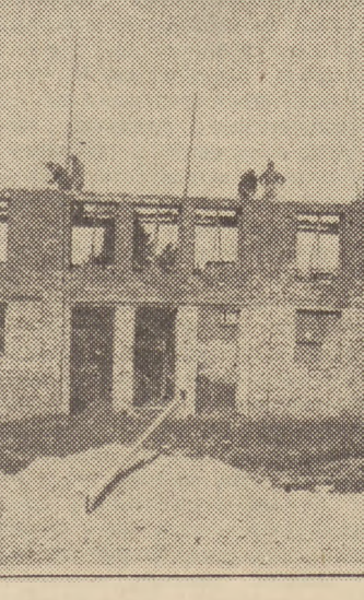
Rosną mury hali sportowej w Osowej
