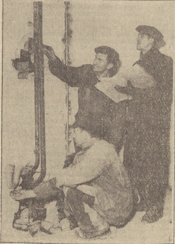
Kierownik budowy Paweł Sielewicz wraz z hydraulikami Edmundem Lewandowskim i Władysławem Sołką uzgadniał dokumentację instalacji centralnego ogrzewania w salach Zbrojowni. Fot. Z. Kosiński
