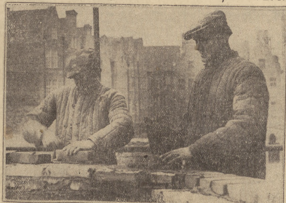
Zalogi budowlane w Gdańsku podjęły zobowiązania, mające na celu przedterminowe i bez- sterkowanie wykonania robót. M. in. brzydka murarska. Edmunda Gruby, pracująca przy odbu- dowie Zbrojowni zobowiązała się wykonać główną klatkę schodową na dwa dni przed ter- minem.
