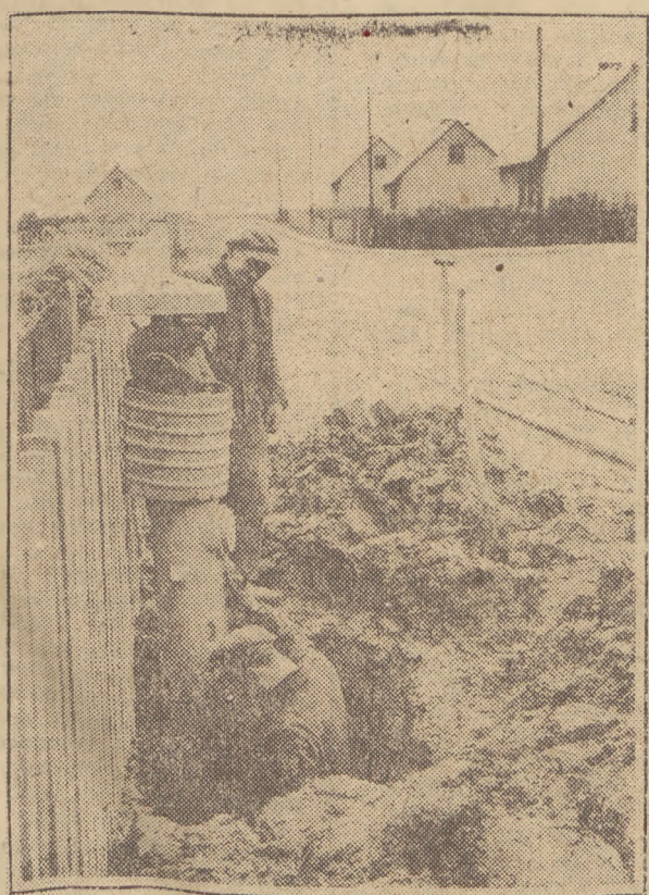
Członkowie spółdzielni produkcyjnej — Kółkowskiej pow. Starogard (woj. gdańskie), dbając o należytą ochronę przeciwpożarową swego mienia, zakładają na terenie spółdzielni hydranty.
