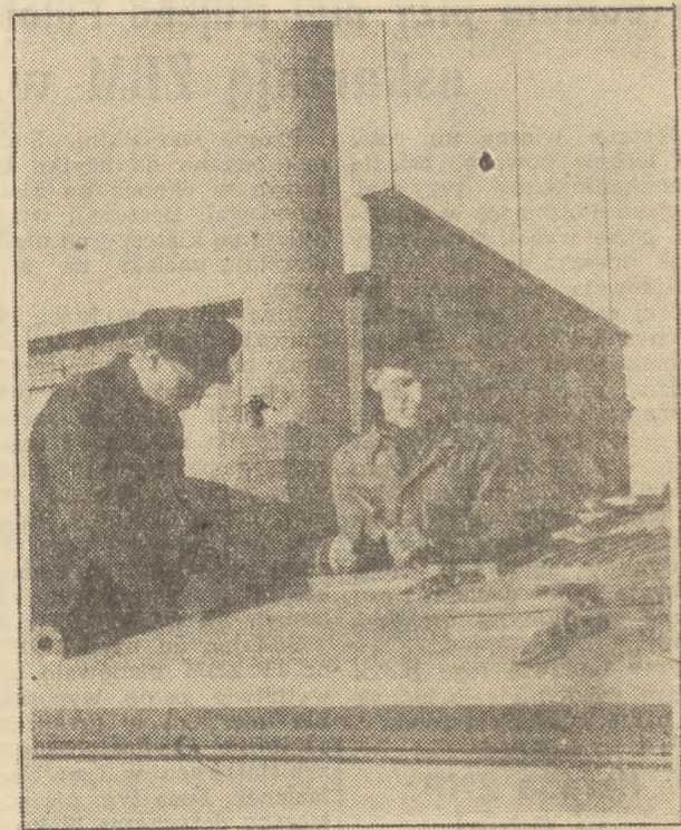
Stefan Sobociński i Stanisław Dąbrowski z Fabryki Wyrobów Metalowych M-12 w Rumi - Zagórze wykonali w Cynie Przedzjazdowym jeden świetlik ponad plan, zaoszczędzając przy tym 980 roboczogodzin. Świetlik ten został wykonany z odpadów blacki przeznaczonych na złom. Robotnicy osiągnęli 220 proc. normy.
