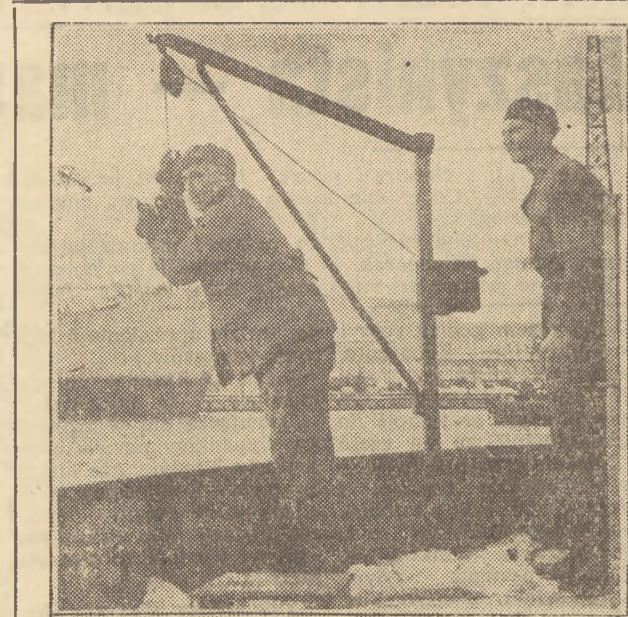
Jednostki taboru pływającego ZPGR w porcie gdyńskim podjęły szereg zobowiązań dla uczczenia II Zjazdu Partii. M. in. załoga barki B-6, służącej jako baza magazynowa w strefie uolnowej, wykonała konserwację sprzętu cumowniczego i całego inwentarza oraz wyremontowała sposoby gospodarstwa ochronę burt.
