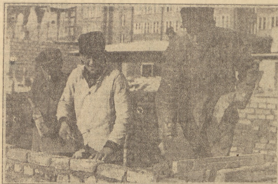
Przy ulicy Ogarej w Gdańsku trwają intensywne prace przy zakładaniu fundamentów pod budowę gdańskich kamienicek. Na zdjęciu: produkująca brygada murarska w składzie (od lewej) Józef Kobiela, Zygmunt Wejman i Marian Michalski przy murowaniu piwnic na budowie nr G001/18 S. Fot. J. Staszewicz
