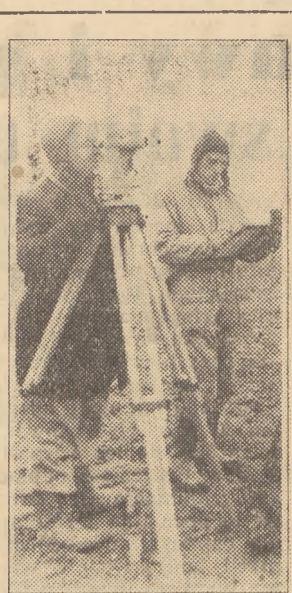
Biuro Projektów Wodno-Melioracyjnych oddział w Poznaniu, przeprowadza na terenie rejonowego biura Wodno-Melioracyjnego w Gdańsku pomiary sytuacyjne na polach spółdzielni produkcyjnej Długie Pole. Są to prace wstępne do melioracji gruntów spółdzielczych. Na zdjęciu: Edmund Witman i Tadeusz Grabuśki przy pomiarach pól spółdzielczych. Fot. Z. Kosycarz.
