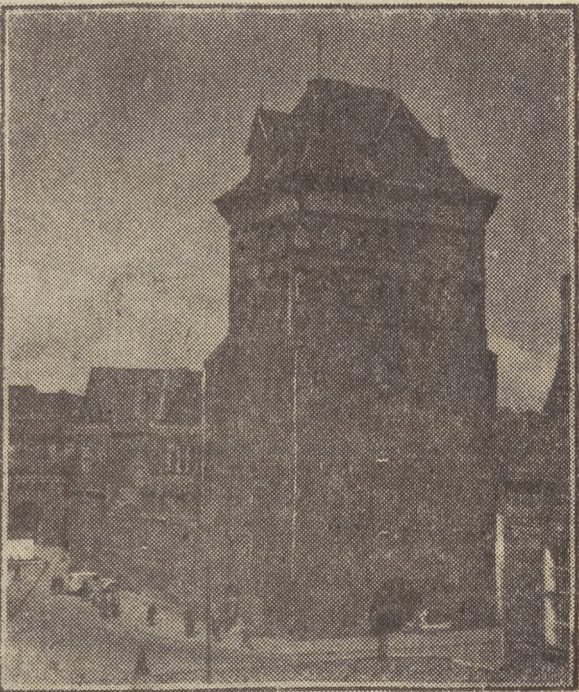
Obecny widok Wieży Więziennej od strony ul. Długiej.
