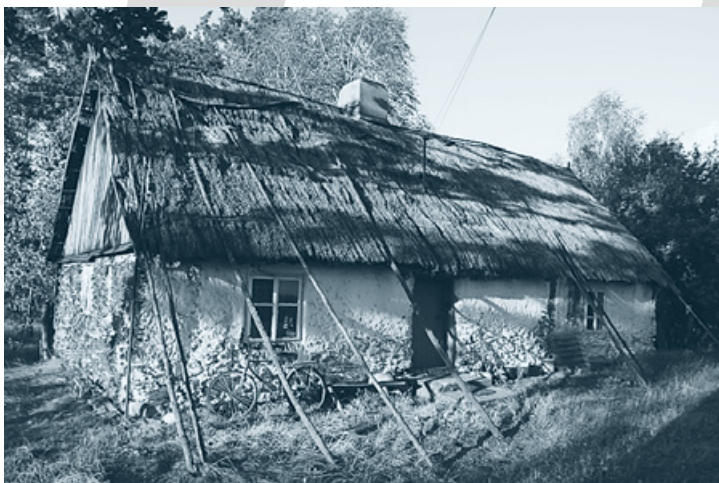
Budynek mieszkalny – konstrukcja z rudy darniowej, szczyty szalowane deskami, Nowolipsk, 2009
