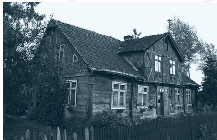
Jegłownik, dawniej Nowy Dwór Elbląski – budynek mieszkalny o konstrukcji mieszanej.
