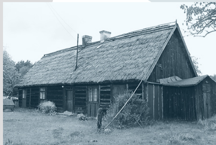
Budynek mieszkalny – konstrukcja zrębowa, szalowany deskami, Piskory, 2009, (fot. P. Mikołajczak)
