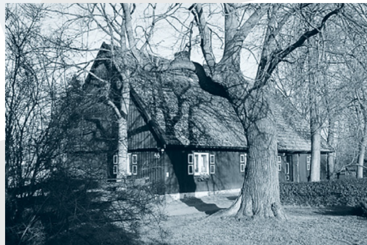
Budynek mieszkalny – konstrukcja zrębową, szalowany deskami, Paproć, 2007
