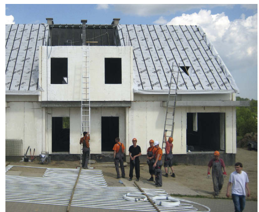
Zdjęcie z budowy domu testowego w Warznie (woj. pomorskie)
