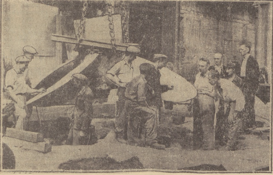
Produkcja śrub okrętowych w Zakładach Mechanicznych w Elblągu.
