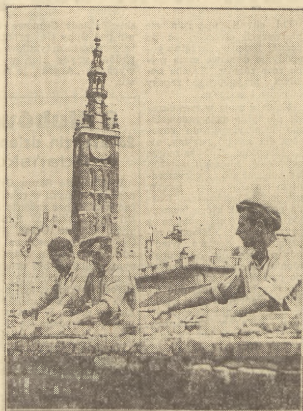
Kompleksowa brygada rozpoczęła pracę na budowie domu przy ul. Ogarej.
