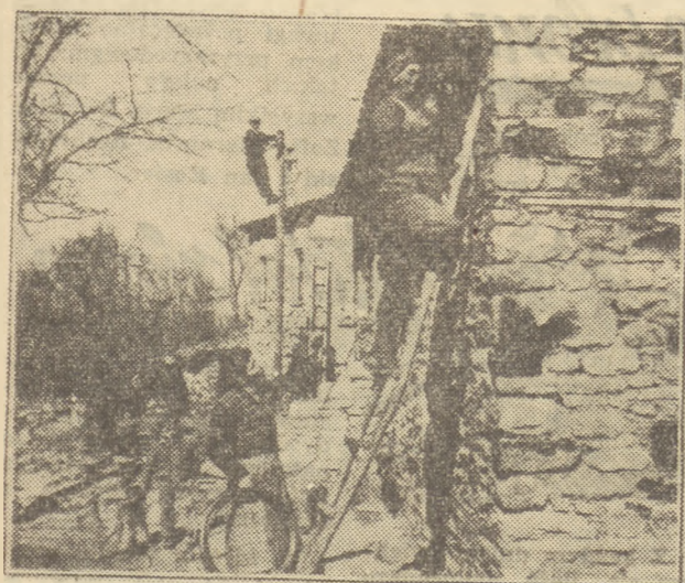
Przed wojną w Albanii elektryczność posiadało zaledwie kilka miast. Obecnie zaś elektryfikowano już nawet większość wsi. Chłopi albańscy coraz szerzej korzystają ze światła elektrycznego i radia. Na zdjęciu: zakładanie instalacji elektrycznej we wsi Rabochlisa koło Kortcha.
