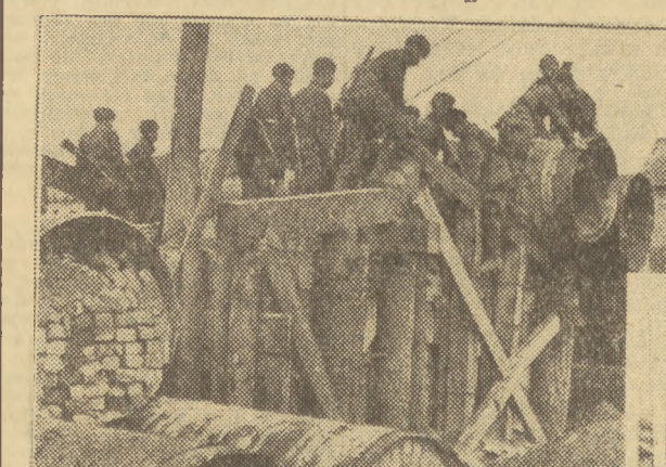
Zołnierze radzieccy budują zapory na ulicach Gdyni.
