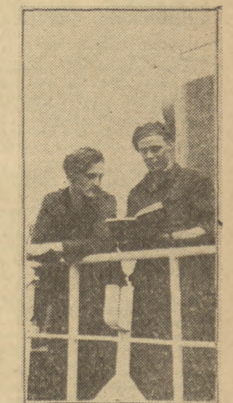
Budowniczy jednostki „S-354” Jerzy Nowak i inż. Jerzy Skrzypek, kier. wydziału montażu silników, ugodnioną pewne poprawki przed wyjściem jednostki w morze.
