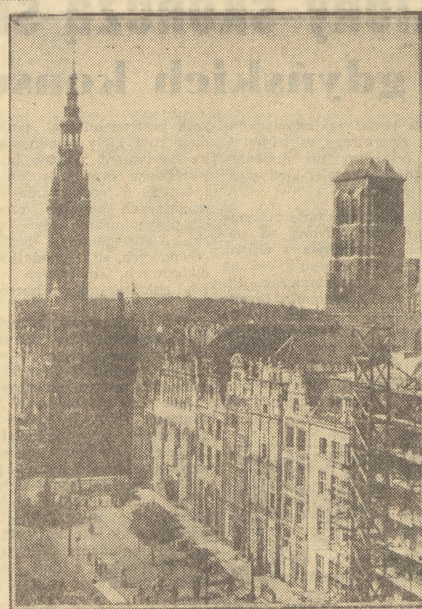
Rekonstrukcja Drogi Królewskiej ciągnącej się od Złotej Bramy do Zielonego Mostu na Motławie — znajduje się już na ukończeniu, tak samo jak elewacje domów znajdujących się przy tym ciągu. Dobrze byłoby jednak, aby Prezydium MRN w Gdańsku przedsięwzięło energiczne kroki celem uporządkowania ulicy i przeniesienia trakcji tramwajowej, której nie oddają sterczące słupy.
