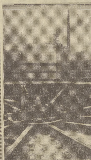
Na zdjęciu: Fragment zakładów; na pierwszym planie budowa nowoczesnej wieży granulacyjnej.
