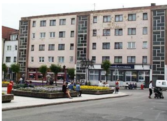
Rysunek 35 Stary Rynek w Chojnicach przed modernizacją / Źródło: Urząd Miejski w Chojnicach
