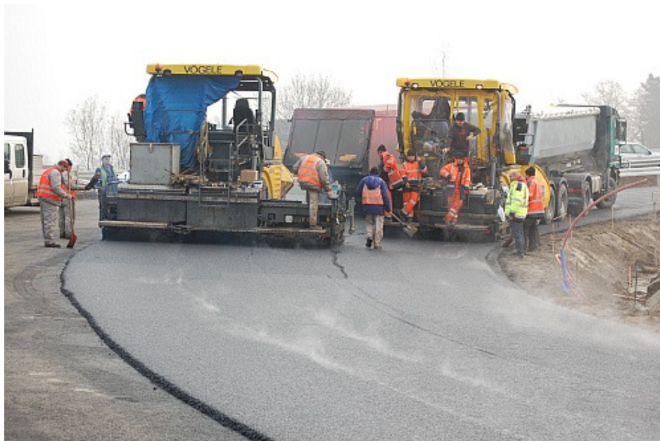
Fot. 6.2. Rozkładanie mieszanki SMA wyprodukowanej ze środkiem Ceca Base RT równocześnie przez dwie rozkładarki
