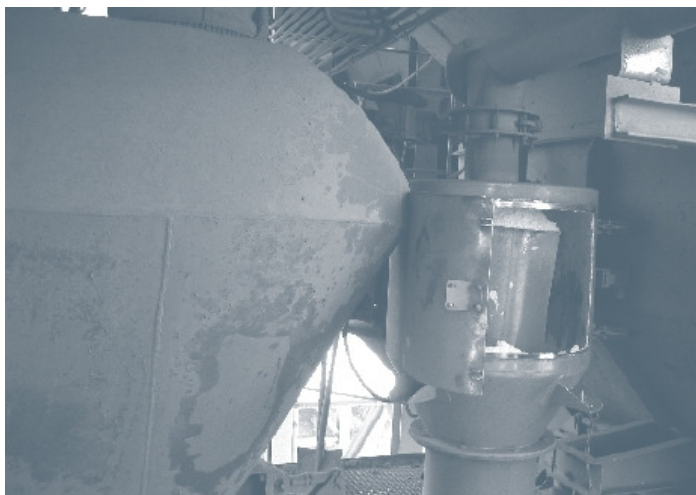
Fot. 2.14. Zasobnik wagowy służący do odmierzania ilości zeolitu [22]
