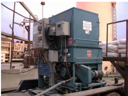
Fot. 2.2. Pneumatyczny dozator Sasobitu. W dolnej części widoczny ciśnieniowy przewód transportujący granulki [21]
