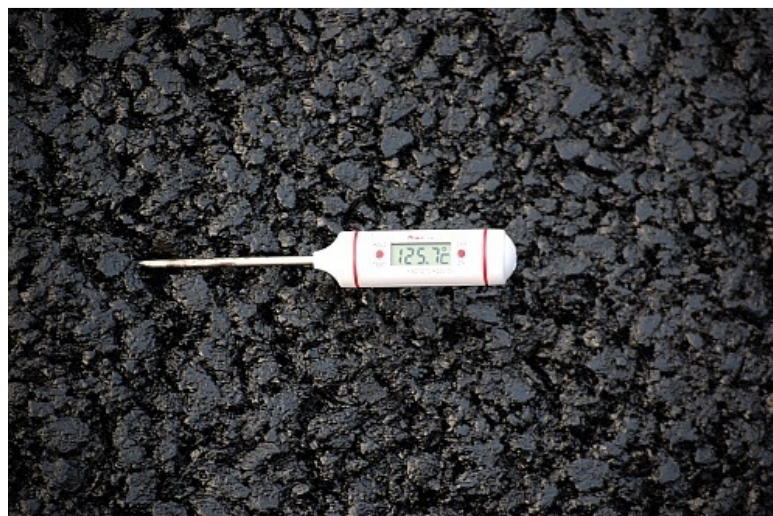
Fot. 6.4. Jeden z pomiarów temperatury mieszanki w trakcie układania
