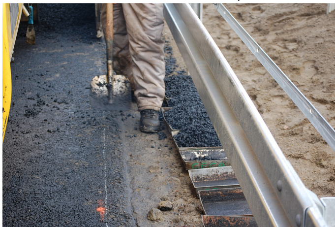
Fot. 6.5. Pobieranie mieszanki SMA z zasobnika rozkładarki mas bitumicznych
