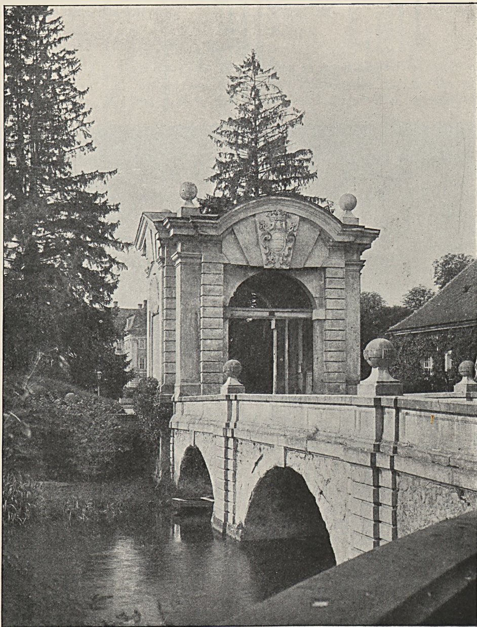
Fig. 68. Joachimstein, Schloß, zweite Brücke und Eingangstor.
