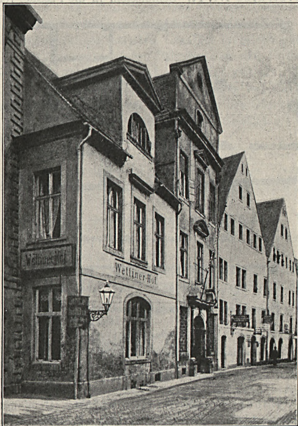
Fig. 269. Wettiner Straße Nr. 2, Fassade
