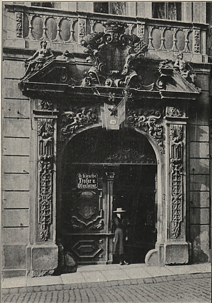
Fig. 248. Weberstraße Nr. 20, Haustor.
