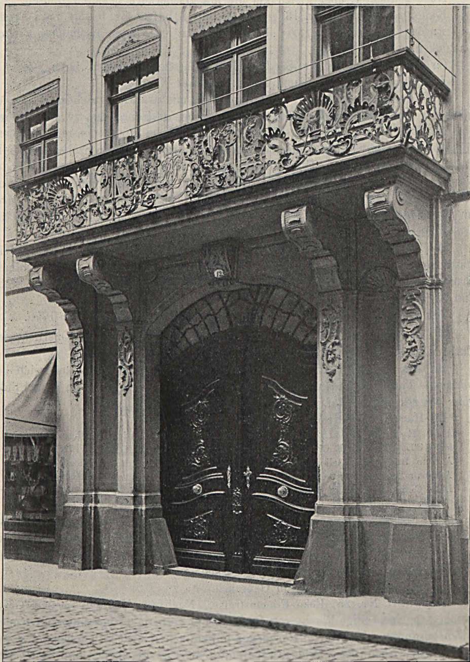
Fig. 266. Weberstraße Nr. 12, Haustor.
