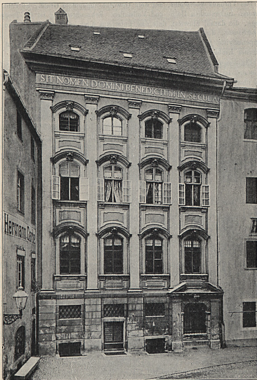
Fig. 235. Markt Nr. 4, Rückfassade (Johanniskirchhof).
