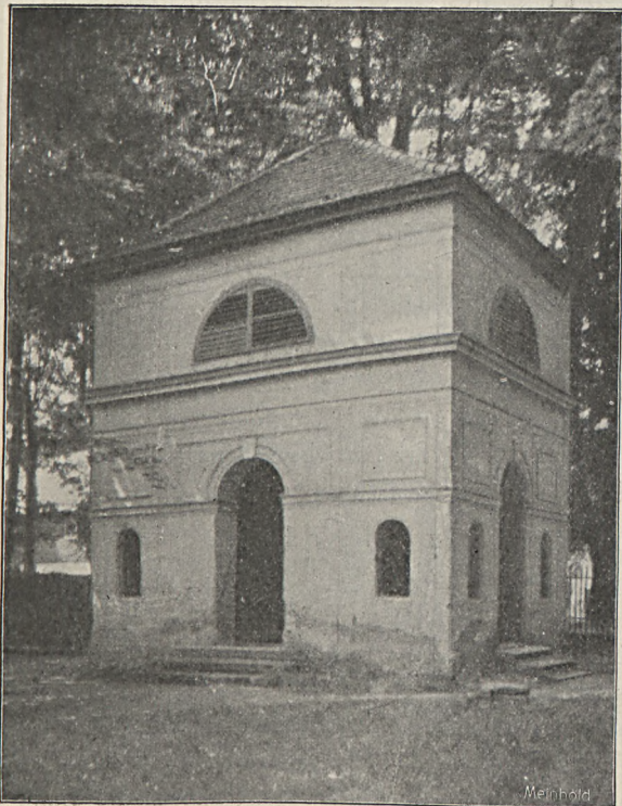
Fig. 279. Gaußig, Park, Pavillon.
