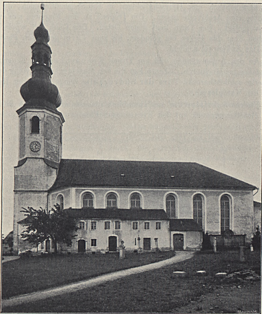
Fig. 200. Hochkirch, Kirche, Nordseite.
