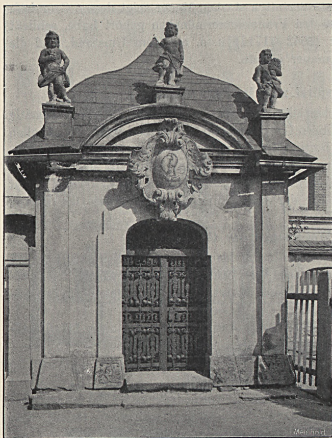
Fig. 325. Löbau, Frauenkirchhof, Rudolphsche Gruft.
