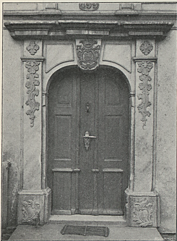
Fig. 128. Eibau, Haus Nr. 499, Korbbogentor.
