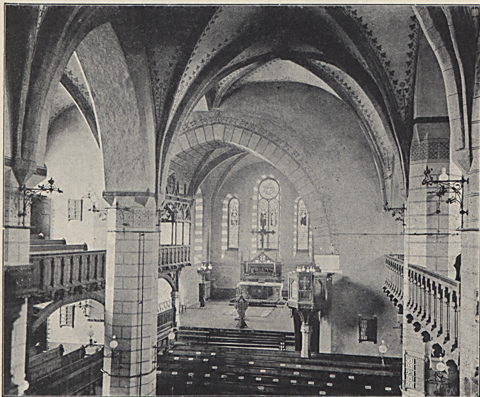
Fig. 272. Löbau, Nikolaikirche, Blick in den Chor.
