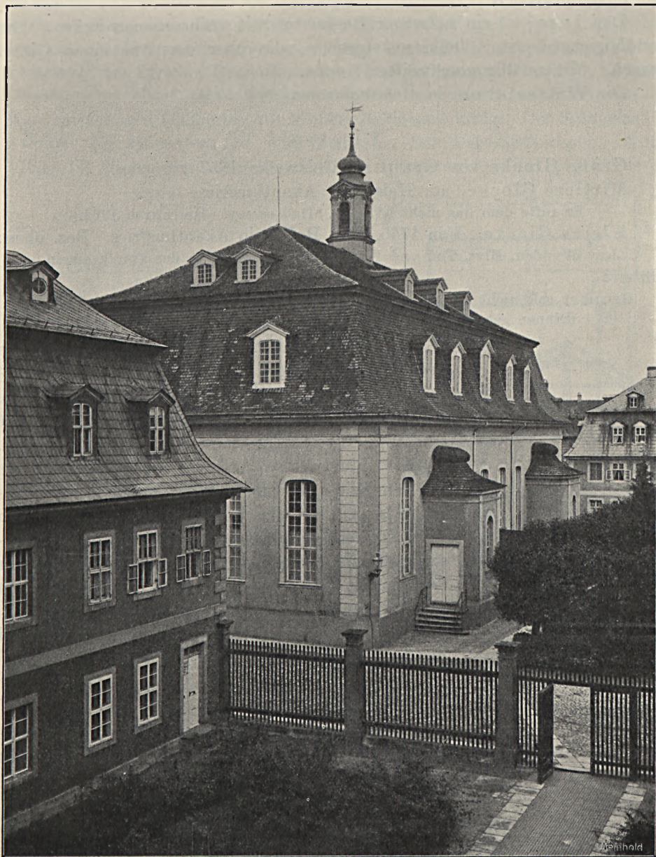
Fig. 166. Herrnhut, Gemeinnsaal, vom Schwesternhaus gesehen.
