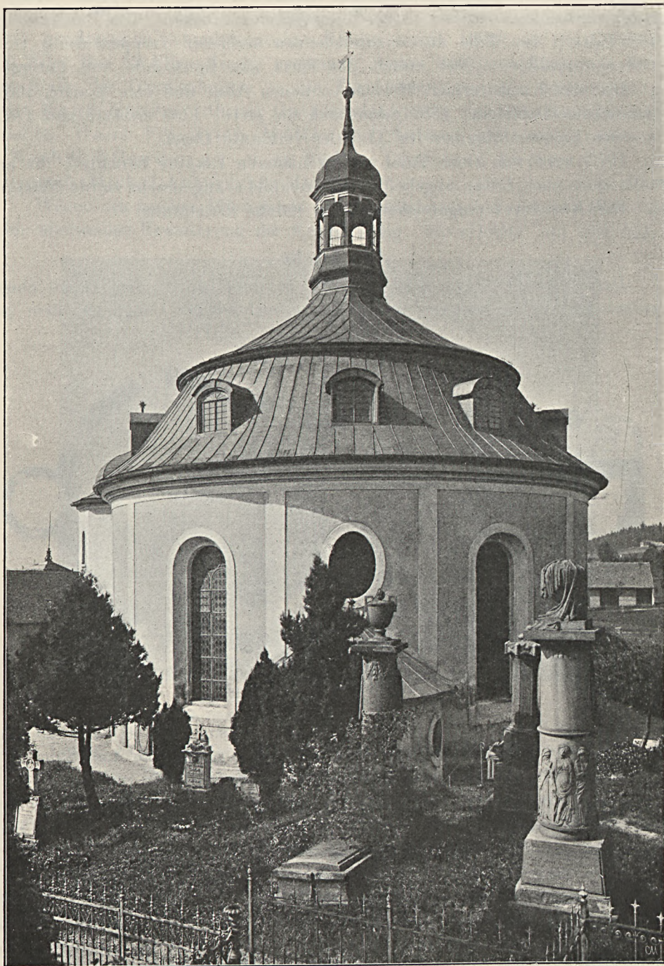
Fig. 91. Ebersbach, Ostansicht der Kirche.
