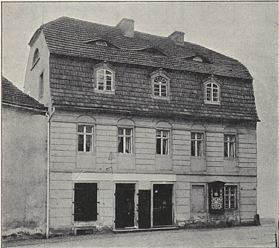
Fig. 416. Löbau, Zittauer Straße Nr. 34.
