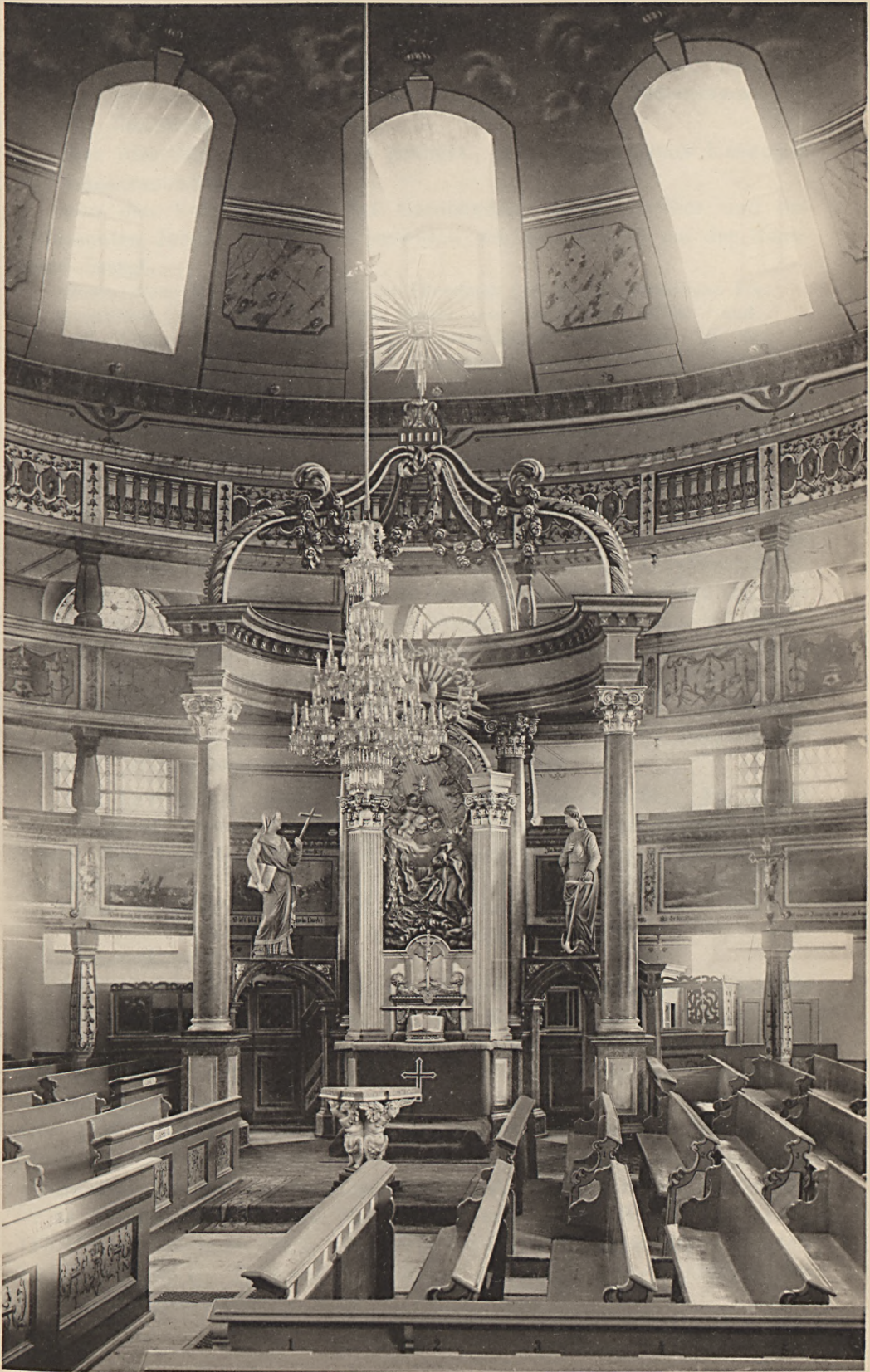
Ebersbach, Kirche, Blick in den Chor.
