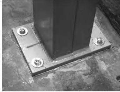
Rys. 4.13. Mocowanie podstawy słupa wsporczego
