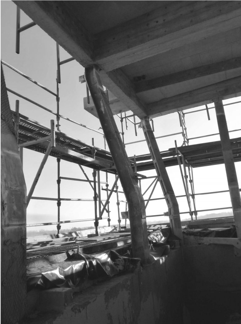
Rys. 1.5. Stalowa konstrukcja prętowa podtrzymująca stropodach wieży
