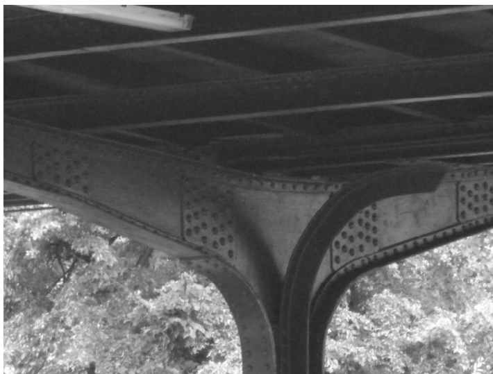
Rys. 1.1. Nitowany węzeł stalowej konstrukcji prętowej
