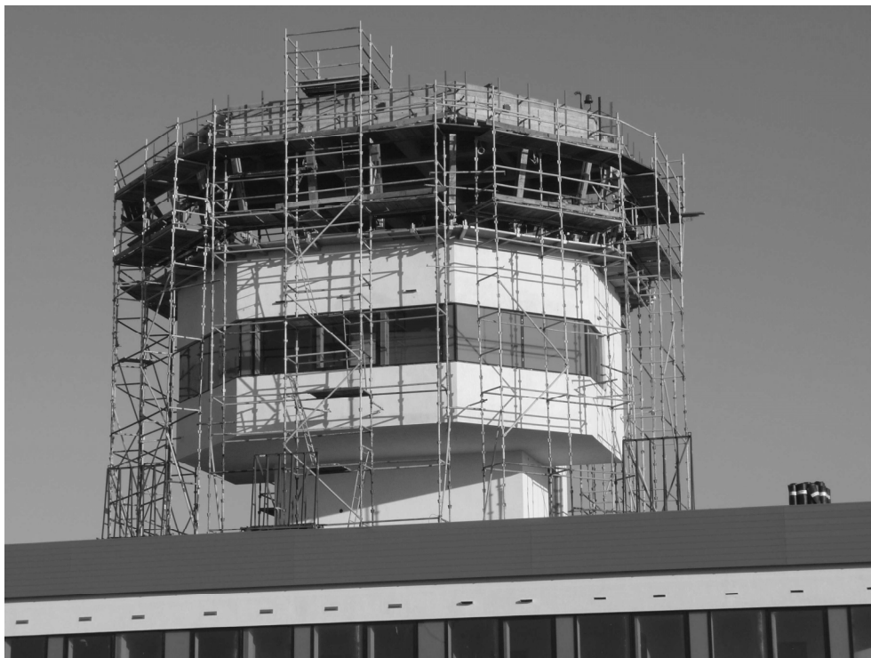
Rys. 1.4. Wieża obserwacyjna w trakcie budowy
