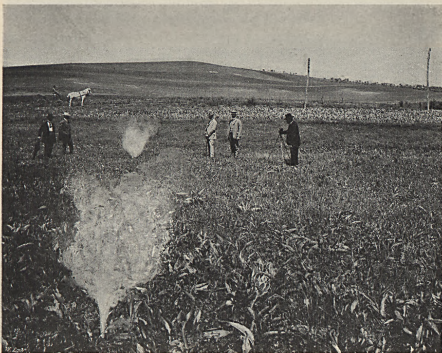
Fig. 13. Hervorbrechendes Erdgas auf der Bánffy -Wiese nach Absperrung des Gasbrunnens am 27. Juni 1910.
