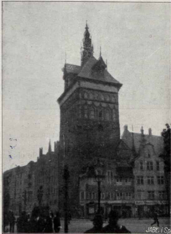
WIEZIENNA WIEŻA Z R. 1346. DACH Z R. 1587.
