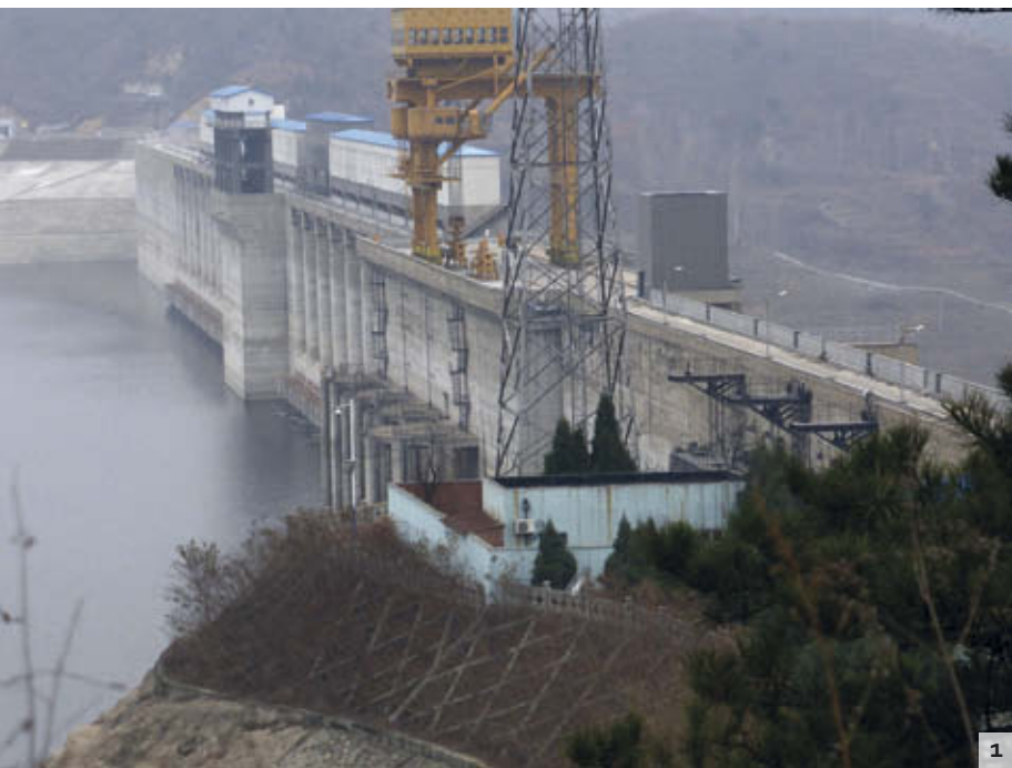
Fot. 1. Zapora Panjiakou w północno-wschodnich Chinach (prowincja Hebei), w pobliżu Wielkiego Muru. Budowa została ukończona w 1981 roku; wysokość zapory wynosi 107,50 m, długość – 1040 m, moc elektrowni – 420 MW, pojemność zbiornika – 3,0 \cdot 10^9 m 3 , powierzchnia zbiornika – 67 km 2 (widok od wody górnej)
