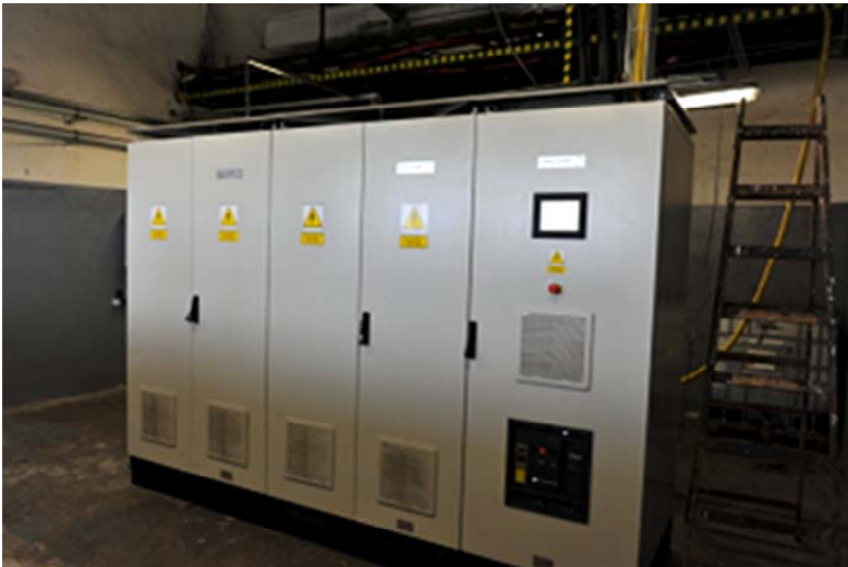
Rys. 4.8. Elementy układu: a) jedna z dwóch maszyn wyciągowych szybu wydobywczego, b) RKA o mocy znamionowej 2 MVA, złożony z dwóch modułów 1 MVA, przyłączonych do sieci poprzez zintegrowany obwód sprzęgający LCL
