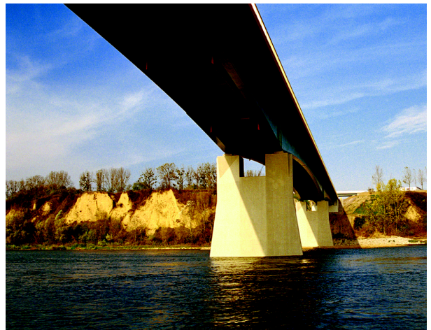
Ryc. 5.26d. Posadowienie przyczółka mostu nie zniszczyło ciągłości skarpy (fot. autora)
