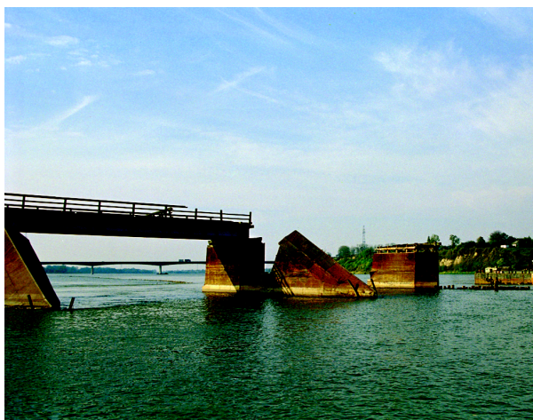
Ryc. 5.27d. Trwa rozbiórka starego mostu w Wyszogrodzie. W tle widoczna jest nowa przeprawa mostowa (fot. autora)
