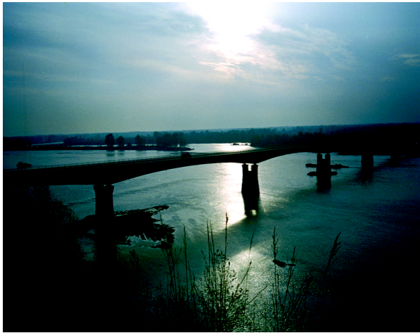
Ryc. 5.26a. Wisła po realizacji mostu zachowała swój naturalny charakter, pozostały stare ramiona rzeki i łachy wiślane (fot. autora)
