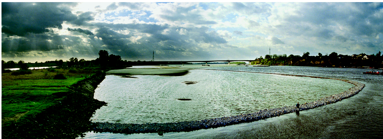
Ryc. 5.27a. Przeprawa mostowa przez Wisłę pod Wyszogrodem – negatywne zjawiska wizualne spowodowane regulacją Wisły. Płytke, tańsze posadowienie pali pod podpory mostu w części zalewowej spowodowało, że regulacja stała się niezbędna dla zapewnienia stabilności mostu. Wywołuje ona przy niskich i średnich stanach wody niekorzystne skutki w sferze wizualnej. Głębokie posadowienie pali w całym przekroju poprzecznym koryta rzeki spowodowałoby, że regulacja rzeki nie byłaby potrzebna (fot. autora)
