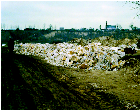
Ryc. 5.26e. Nasyp technologiczny niezbędny dla budowy mostu został zlikwidowany w myśl zaleceń z raportu OOS (fot. autora)
