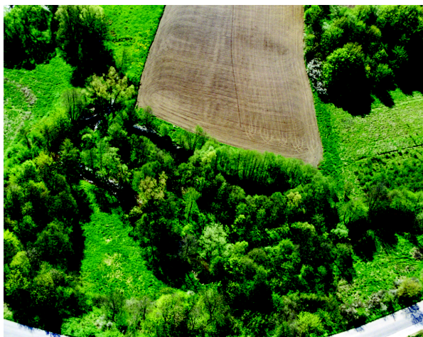
Ryc. 5.2d. Przygotowany pas pod realizację autostrady A1 pokazuje miejsce przecięcia rzeki Kłodawy. Skutkiem może być zakłócenie funkcjonowania ekosystemu przyrodniczego rzeki (fot. autora)
