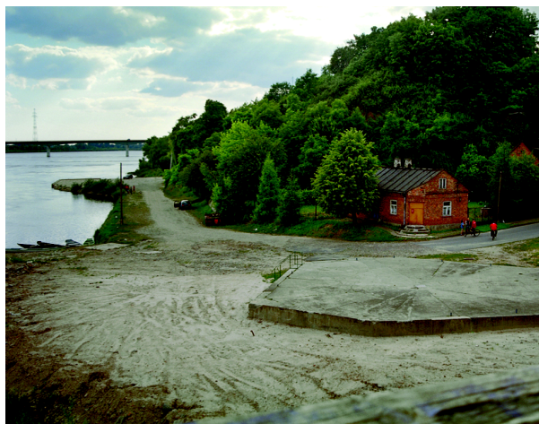
Ryc. 5.27g. Nie zrealizowano nadrzecznego ciągu łączącego nowy most z punktem widokowym na zachowanym prawobrzeżnym przyczółku starego mostu (fot. autora)
