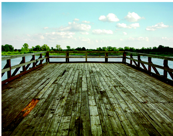
Ryc. 5.27f. Zachowany prawobrzeżny przyczółek starego mostu pokazuje piękno przyrody, ale nie historię mostu. Brakuje jakiegokolwiek informacji turystycznej (fot. autora)
