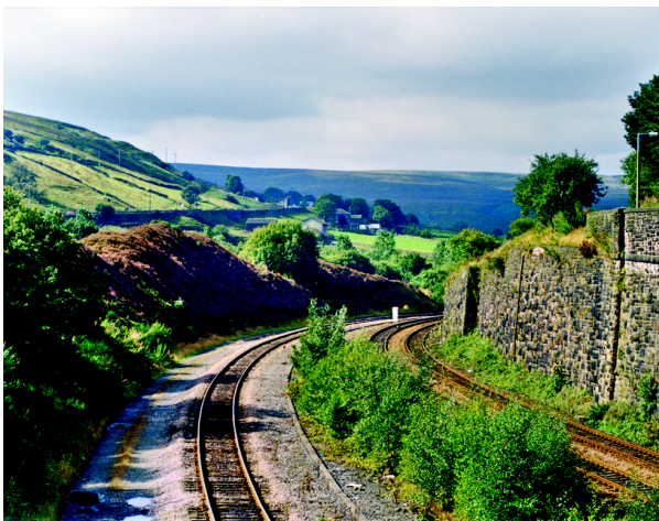
Ryc. 4.2e. Przykładem właściwego dostosowania formy, materiału i rozplanowania obiektów infrastrukturalnych do istniejącego krajobrazu jest widoczne na zdjęciu piękne wpisanie trasy kolejowej w otwarty krajobraz angielskie, przy wykorzystaniu lokalnych materiałów (fot. autora)
