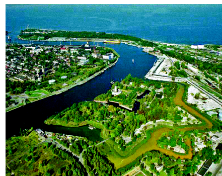
Ryc. 5.7. Do dziś na tkance zabytku i w wodach otaczającej go fosy widoczne są skutki oddziaływania pyłów siarki. Zniekształcona forma pięciobastionowego szanika jest niechlubną pamiątką decyzji o poszerzeniu toru wodnego dla potrzeb stoczni (fot. Z. Grabowiecki)
