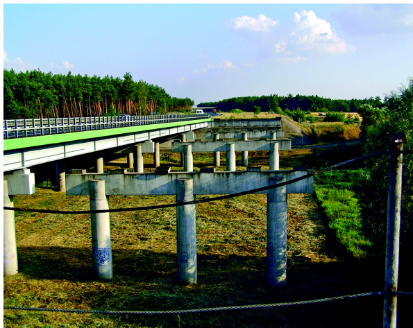
Ryc. 5.2b. Autostrada A1 pod Toruniem przecina rzekę Drwęcę – ichtiologiczny rezerwat przyrody. Widoczne pale posadowione pod konstrukcją drugiej nitki autostrady wytyczają szerokość pasa bezpośredniej ingerencji w środowisko (fot. autora)
