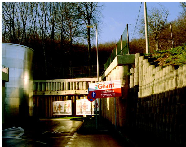
Ryc. 5.32e. Umocnienie skarpy na granicy Trójmiejskiego Parku Krajobrazowego, towarzyszące budowie centrum handlowego kilka kilometrów od trasy, pokazuje możliwe zagrożenia krajobrazu (fot. autora)
