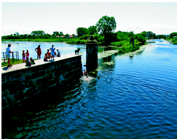
Ryc. 5.18a. Opływ Motławy można bardziej intensywnie zagospodarować rekreacyjnie, tworząc np. wydzielone kąpieliska. Obecne „dzikie” wykorzystywanie akwenu wodnego w pobliżu działającej śluzy stwarza zagrożenie dla użytkowników (fot. autora)
