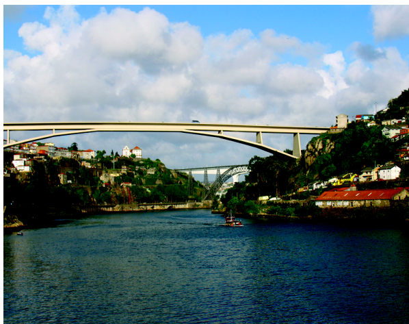
Ryc. 5.1a. Piękne konstrukcje mostowe podkreślają urodę niezwykle go krajobrazu wokół miasta Porto. Widoczne mosty: Ponte Infante Dom Henrique, Ponte Dona Maria Pia, Ponte S. Joao (fot. autora)
