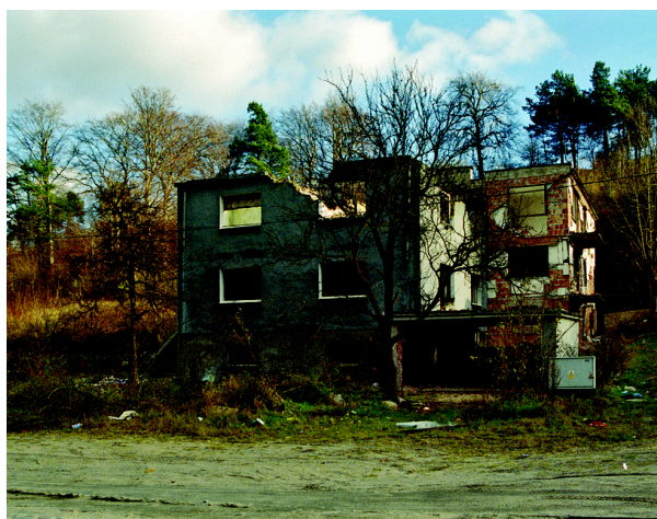
Ryc. 5.32c. Realizacja wariantu „leśnego” Trasy Kwiatkowskiego wiązała się z koniecznością wyburzenia w dolinie Leszczynki kilku domów mieszkalnych o niskim standardzie i przeniesienia ich mieszkańców w inne miejsce (fot. autora)
