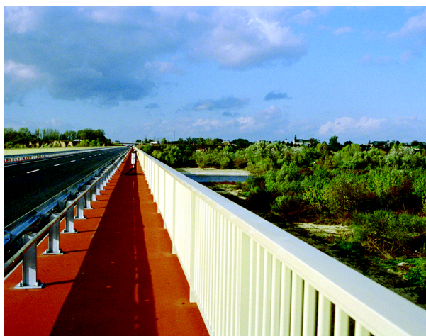
Ryc. 5.27i. Brak punktu widokowego przy wjeździe na nowy most od strony niskiego brzegu utrudnia oglądanie unikatowego krajobrazu skarpy wyszogrodzkiej (fot. autora)
