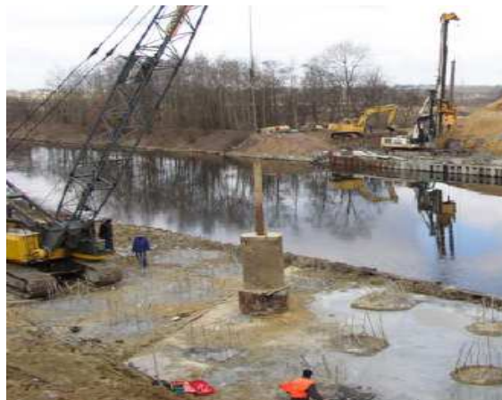
Fot. 5.10. Badanie nośności pali metodą DLT [2].
