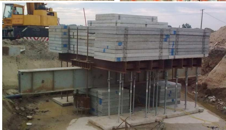
Fot. 5.9. Próbné obciążenie statyczne - stanowisko balastowo-kotwione.
