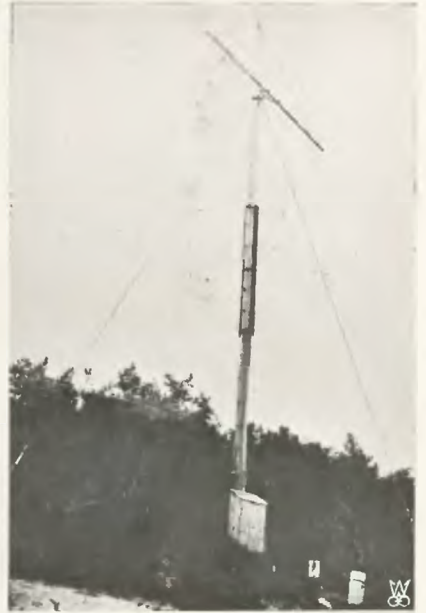
Fig. 3. Mât avertissant en bois a Jastarnia (hauteur 20 m).
