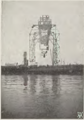
Gdynia. Pont-transbordeur à charbon.
