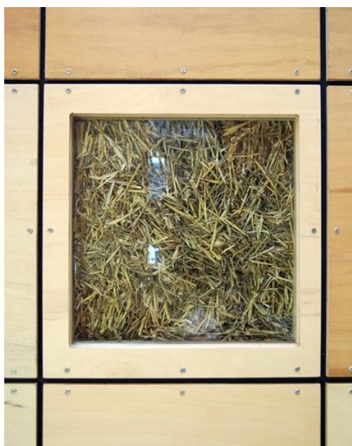
il.16. Fragment przegrody zewnętrznej z widoczną wewnątrz pomieszczenia warstwą izolacji termicznej z bali naturalnej słomy wypełniających szkieletową drewnianą konstrukcję z osłoną z panelu szklanego, kawiarnia uniwersytecka, proj. HewittStudio, Herefordshire, UK, źródło: http://www.jessicarobinthomas.wordpress.com/2012/01/04/its-straw-bale-and-its-beautiful/ , [dostęp: 02.12.2015]
