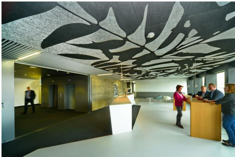
il.33. Przestrzeń komunikacyjna i ogólnodostępna z sufitem podwieszonym wykonanym z płyt z włókna drzewnego zespolonego magnezem serii Heradesign, budynek biurowo-administracyjny, Aachen, 2010, proj. źródło: www.heraklit.com
