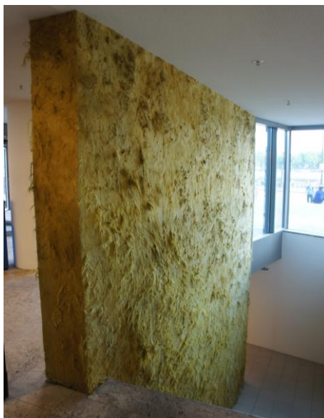
il.11. Hall wejściowy z okładziną ścienną z naturalnej wełny owczej, pochodzącej z hodowli ekologicznych, barwionej substancją naturalną wytworzoną na bazie łusek cebuli. Centralna Biblioteka Publiczna, Amsterdam, arch.Jo Coenen, proj. okładziny wykończeniowej ściany wewnętrznej Claudy Jonstra, 2006, fot. M.Celadyn, 2014
