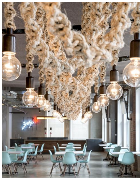
il.46. Sufit podwieszony w strefie konsumpcyjnej biura. Podwieszane maty filcowe z wełny naturalnej gr.5mm uzupełnione sznurami z naturalnego surowca służącymi do mocowania opraw oświetleniowych, biuro YELP, proj.Studio O+A, San Francisco, fot.J.Sanidad, źródło: http://www.archdaily.com/517354/yelp-headquarters-studio-o-a , [dostęp: 24.06.2015]
