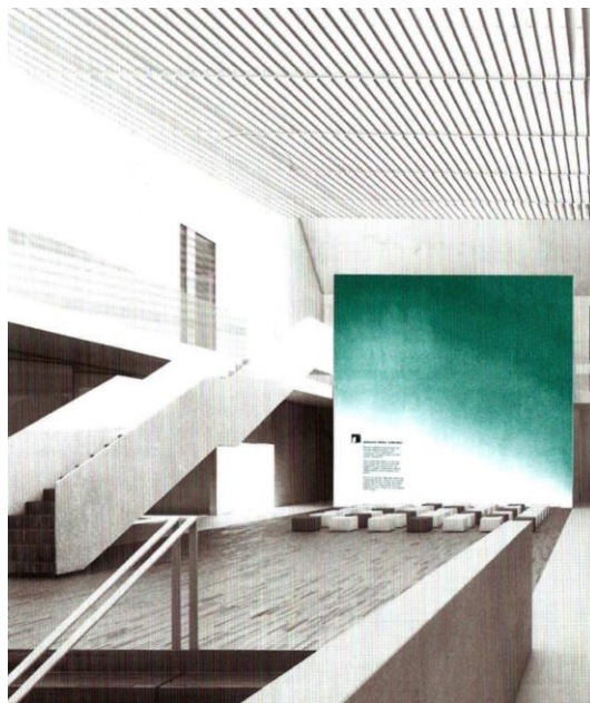
il.17. Wewnętrzna wolnostojąca pełna przegroda w foyer, jako termiczny magazyn akumulacyjny ( thermal storage ), poprzez powłokę wykończeniową termochromatyczną wskazuje zewnętrzną zmienną temperaturę modelu ilustrującą stopień nagromadzenia w nim energii cieplnej. Budynek 3E Politechniki Wrocławskiej, źródło: P.Kuczia, Educating Buildings. Learning Sustainability Through Displayed Design , NUSO Verlag, 2013
