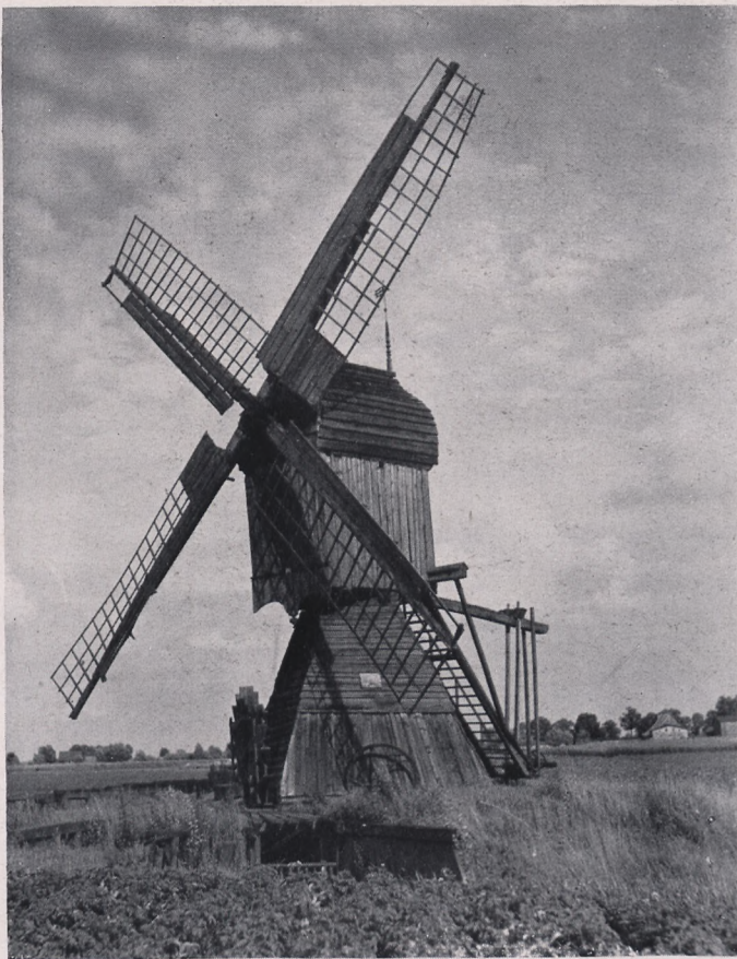
Schöpfwerk bei Schöneberg. Im Aufbau und Konstruktion klein und einfach. In der Umgebung Danzigs eine früher sehr verbreitete Form.
