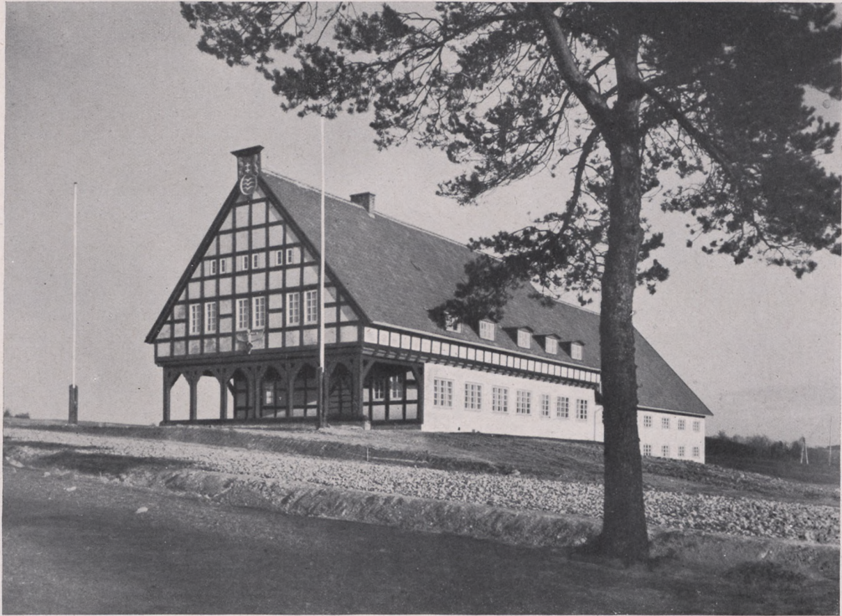
Segelfluglager des NS.-Fliegerkorps Standarte Fritz Schwarz, Danzig. Blick von Westen. Massiver Wohnbau mit Fachwerkgiebel und Drempel. Flugzeughalle an den Hauptbau angebaut. Erbaut in den Jahren 1938/39.
