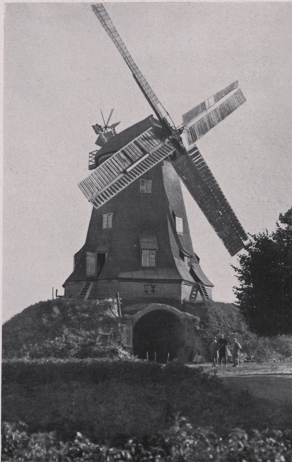
Palschau, Großes Werder. Getreidemühle mit massivem und gewölbtem Unterbau. Der Abbruch dieser schönen Mühle wurde durch Eingreifen der Denkmalpflege 1933 verhindert.
