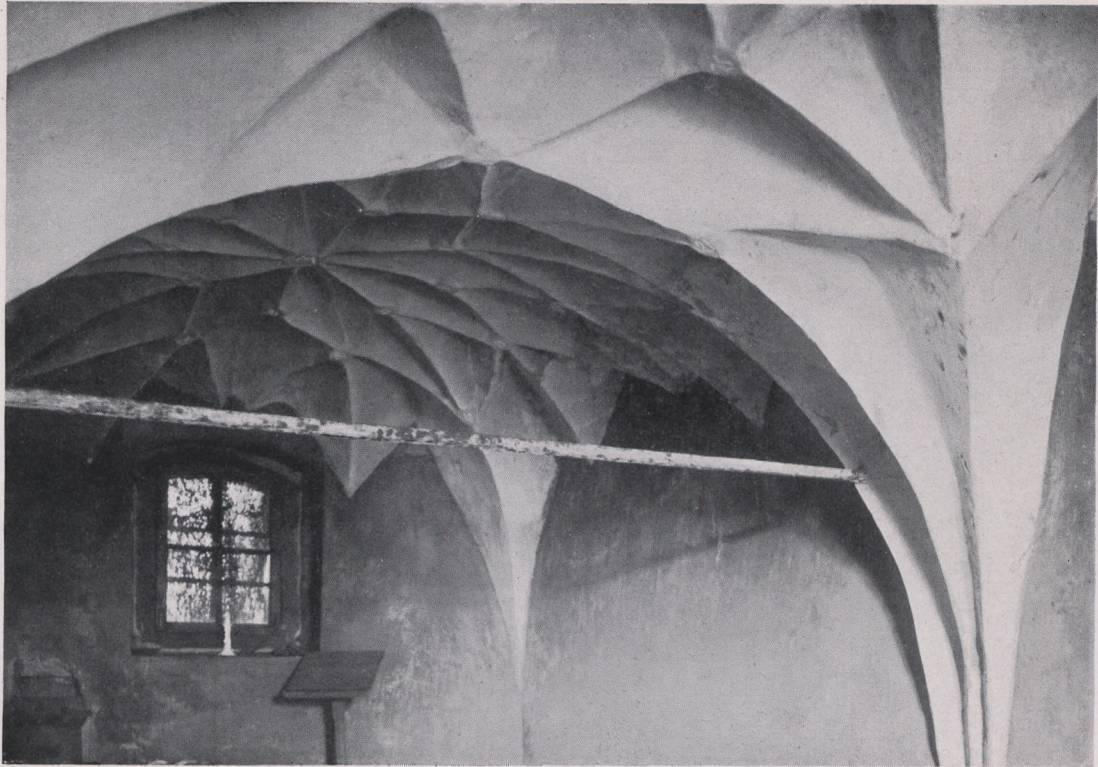
Fürstena u. Ev. Kirche. Zellengewölbe in der Sakristei. Blick auf die West- und Nordinnenwand.
