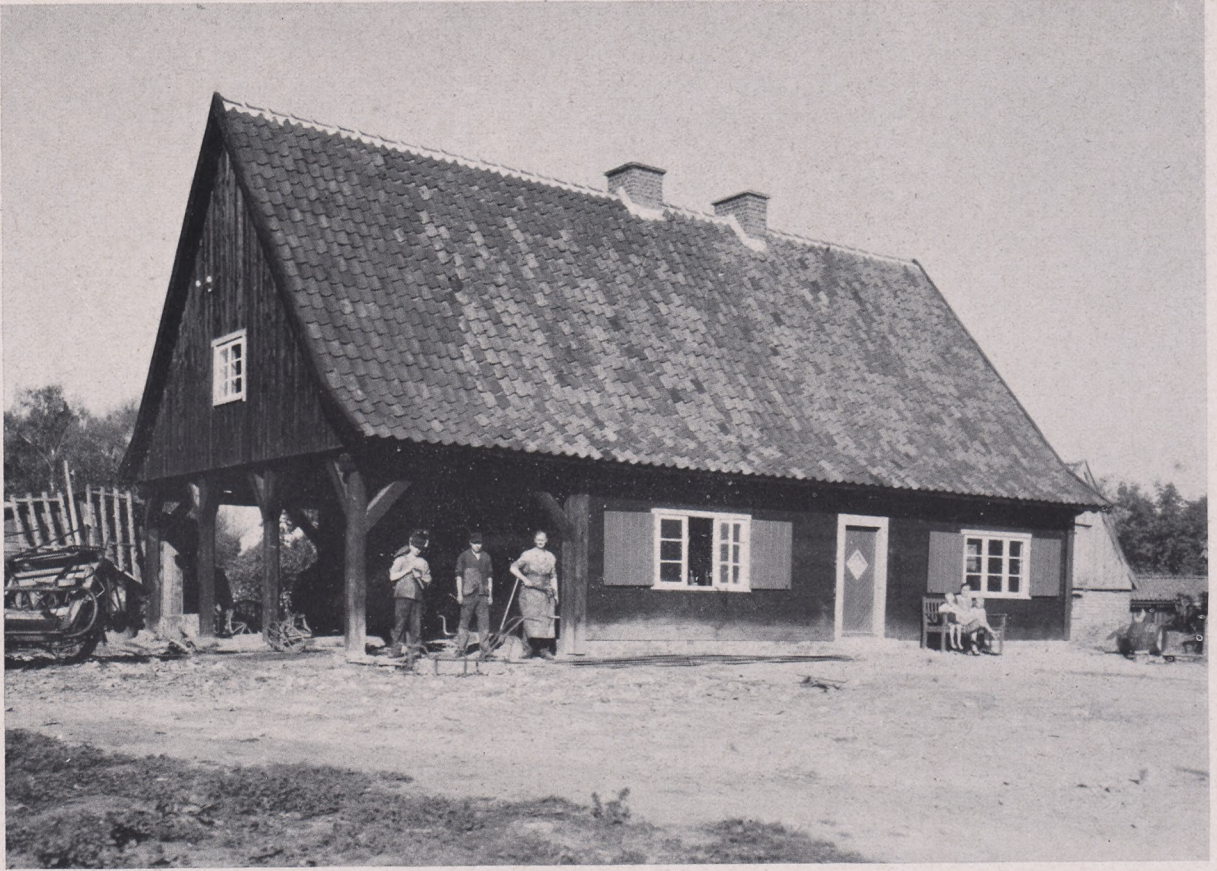
Herzberg, Danziger Niederung. Dorfschmiede. Bohlenbau. Erbaut 1934 mit neuer Innenaufteilung auf der alten Stelle im Dorfanger und unter Bewahrung der alten Außenform.
