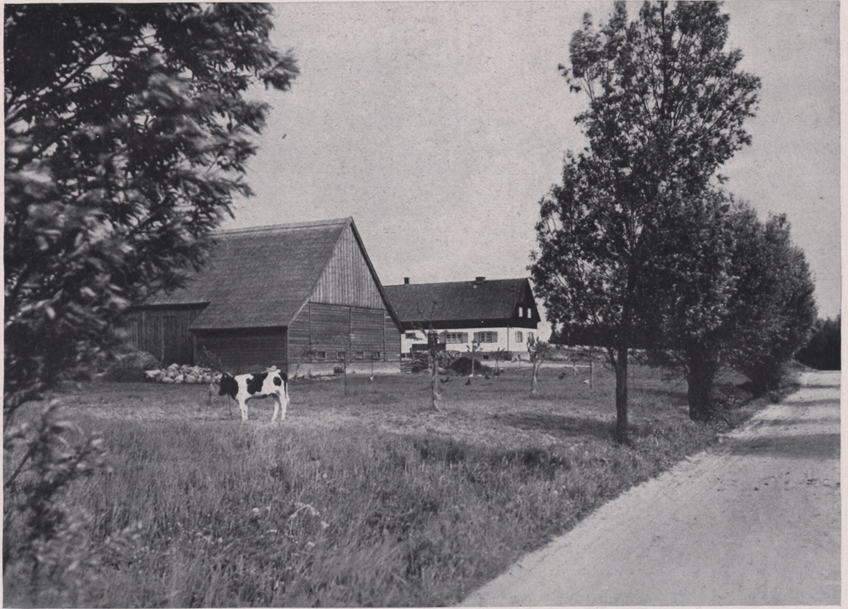
Prangschin, Danziger Höhe. Neubauernstelle, etwa 20 Hektar groß. Erbaut 1937. Wohnhaus mit Stall unter einem Pfannendach. Holzscheune mit Abseiten und Rohrdach.
