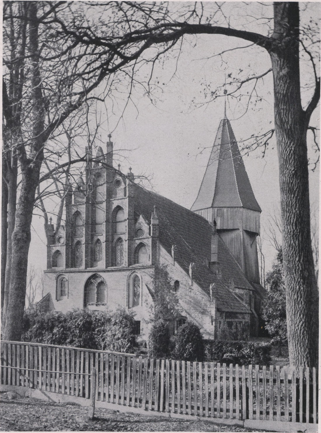
Fürstenaue. Ev. Kirche. Blick auf den Ostgiebel, Sakristei und Turm.
