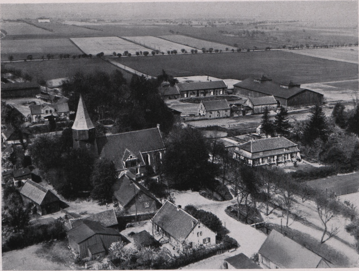
Trutenau. Ev. Kirche mit Pfarrhaus (Mansardendach) und Schule im Vordergrund. Luftbild.
