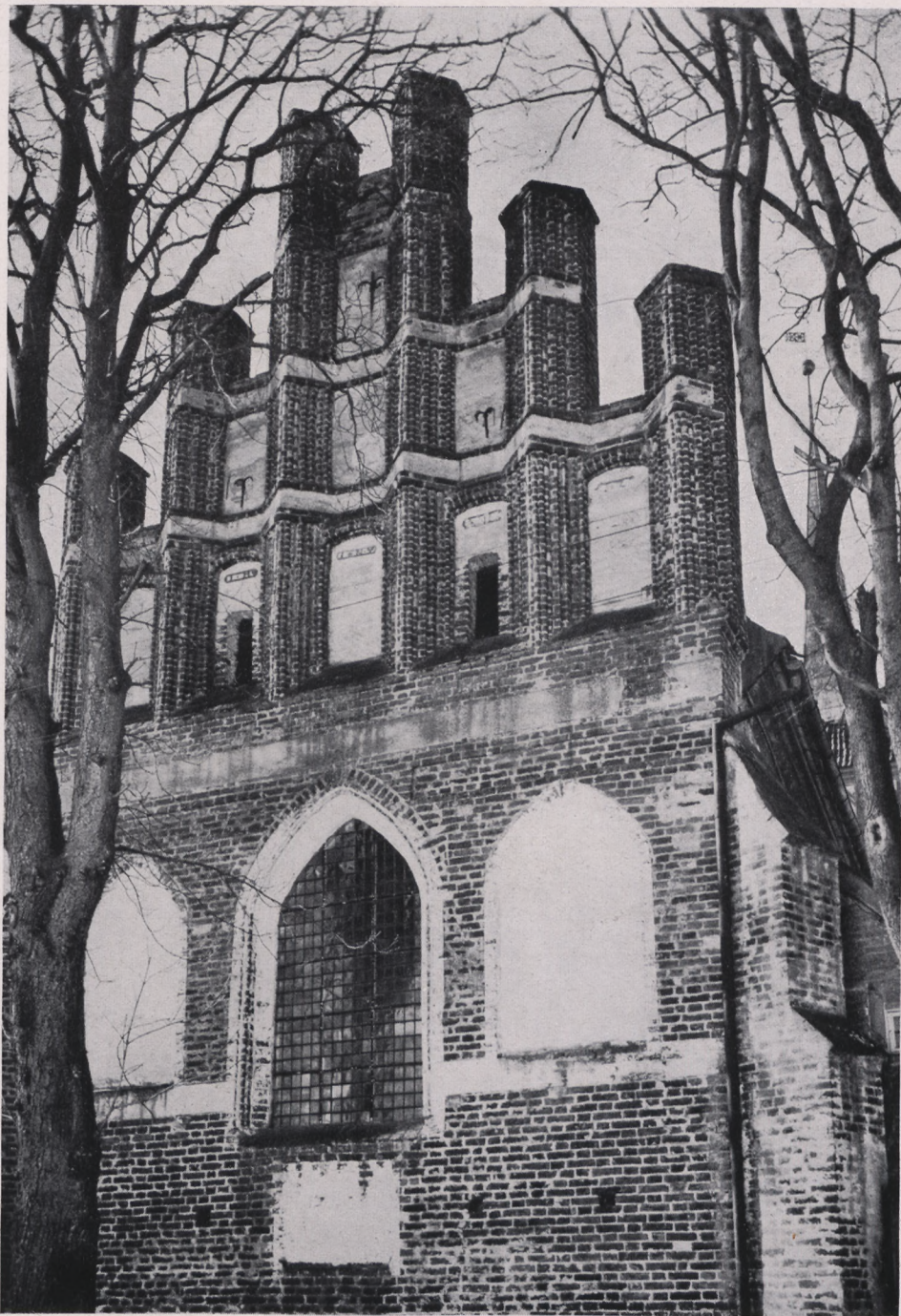
Wotzlaff. Ev. Kirche. Ostgiebel mit reicher Pfeilerprofilierung. Es ist anzunehmen, daß der Giebelaufbau in der Zeit nach den Städtekriegen und der Zerstörung des Dorfes (1465), dagegen der Unterbau in der Ordenszeit (vor 1384) errichtet wurde.
