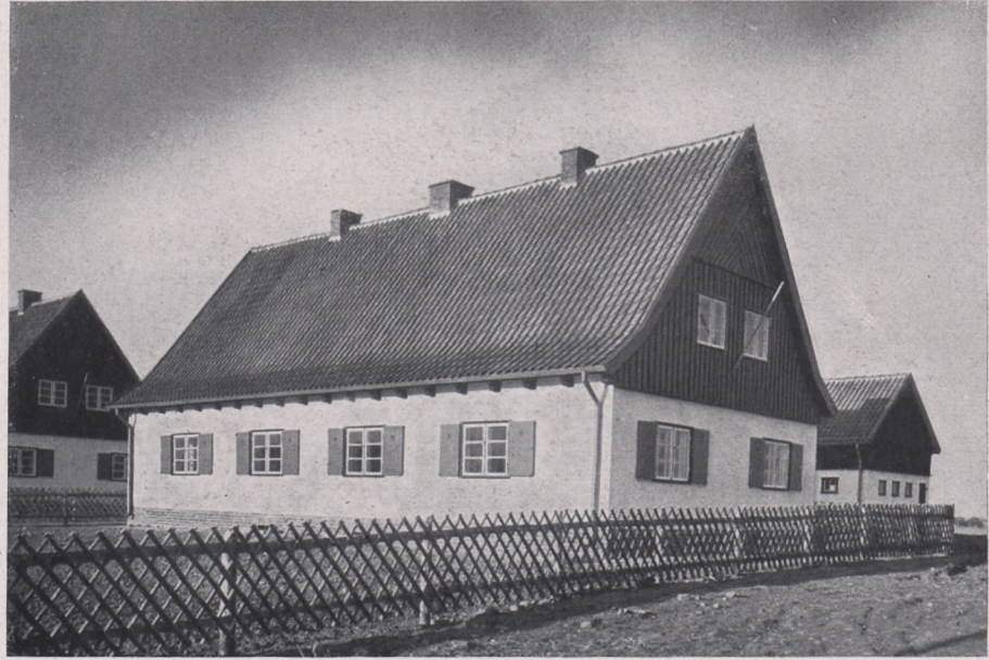
Landarbeiter-Wohnhäuser auf der Domäne Goschin, Danziger Höhe. Neubauten in den Jahren 1936 und 1939.
