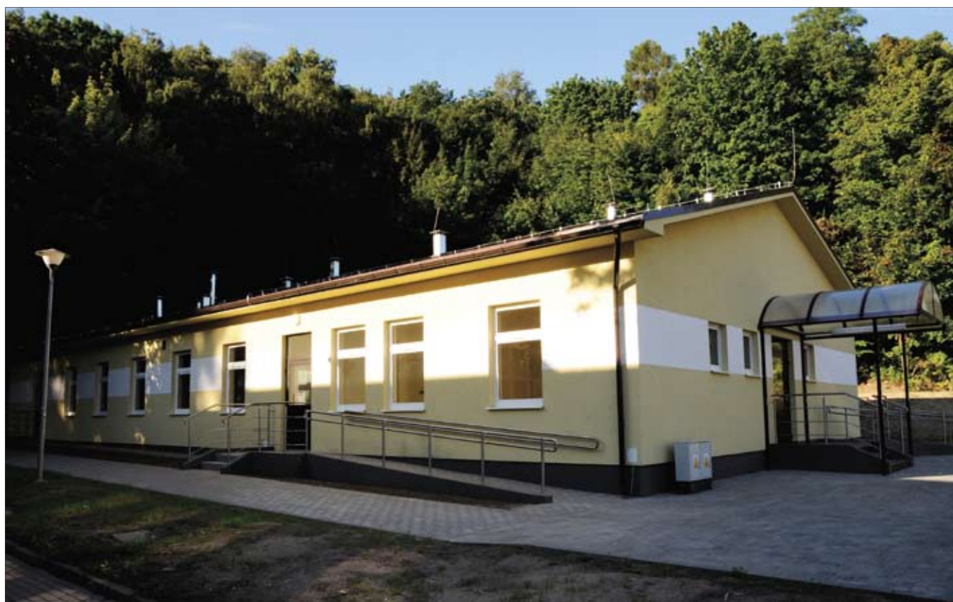
//////////////////////////////////// Budynek dla PET-CT na ukończeniu
