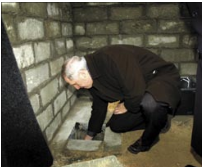
Rektor prof. Roman Kaliszan dokonuje wmurowania aktu erekcyjnego budowy Centrum Naukowo-Badawczego Medycyny Laboratoryjnej AMG
